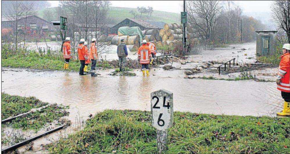
Bahnstrecke gesperrt: Wegen Unterspülung wie hier am Bahnübergang bei Offensen bleibt die Bahnstrecke Göttingen – Bodenfelde auch am heutigen Montag noch gesperrt. Die Bahn hat einen Bus-Ersatzverkehr eingerichtet. Alle Fotos: Durnitz
