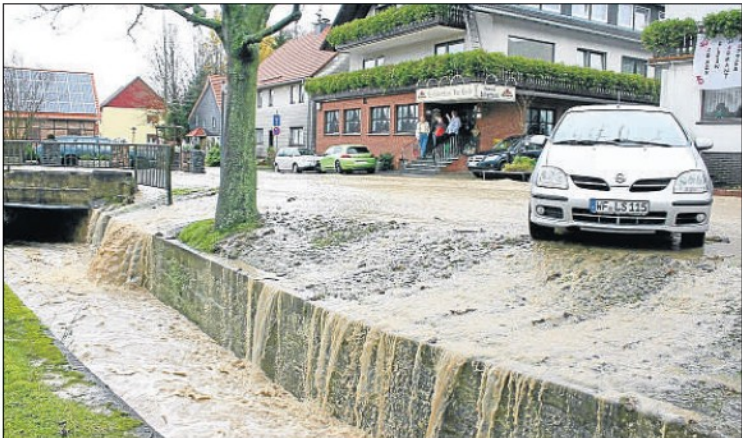
Wasserfluten von der Straße: So viel Wasser wie am Samstag führte der Sahlbach für Fürstenhagen seit den 1940er Jahren nicht mehr, hieß es von Einwohnern, die das Hochwasser beobachteten.
