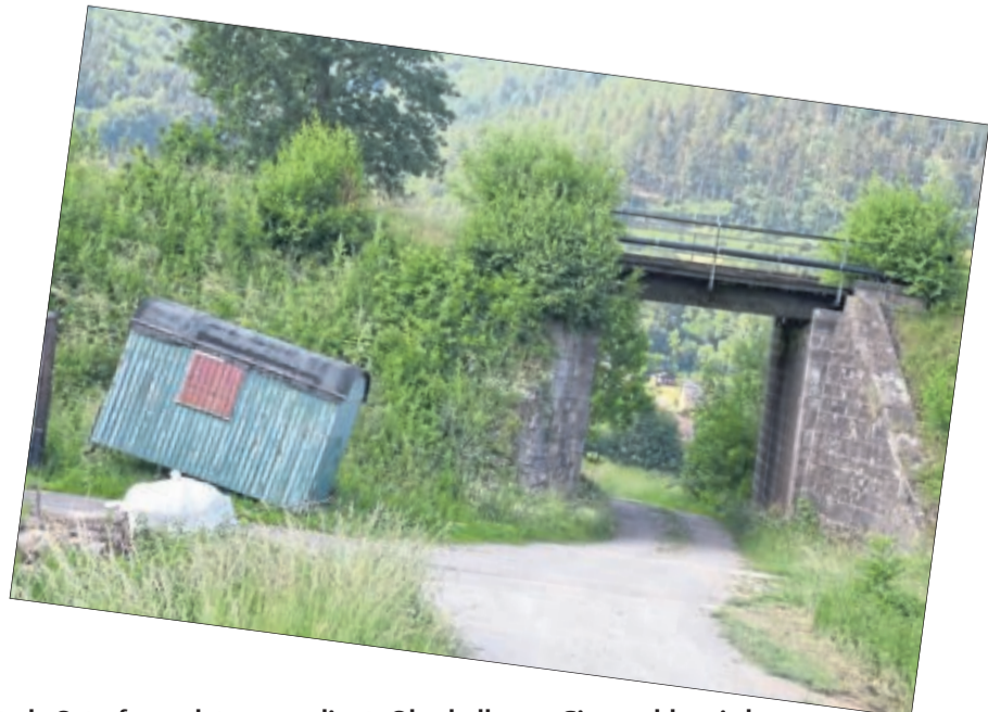
Hat als Osterfeuerplatz ausgedient: Oberhalb von Gierswalde wird die Bahnunterführung (rechts) verfüllt. Wo bisher das Osterfeuer loderte (links), soll bis 2023 die neue Bundesstraße verlaufen.
