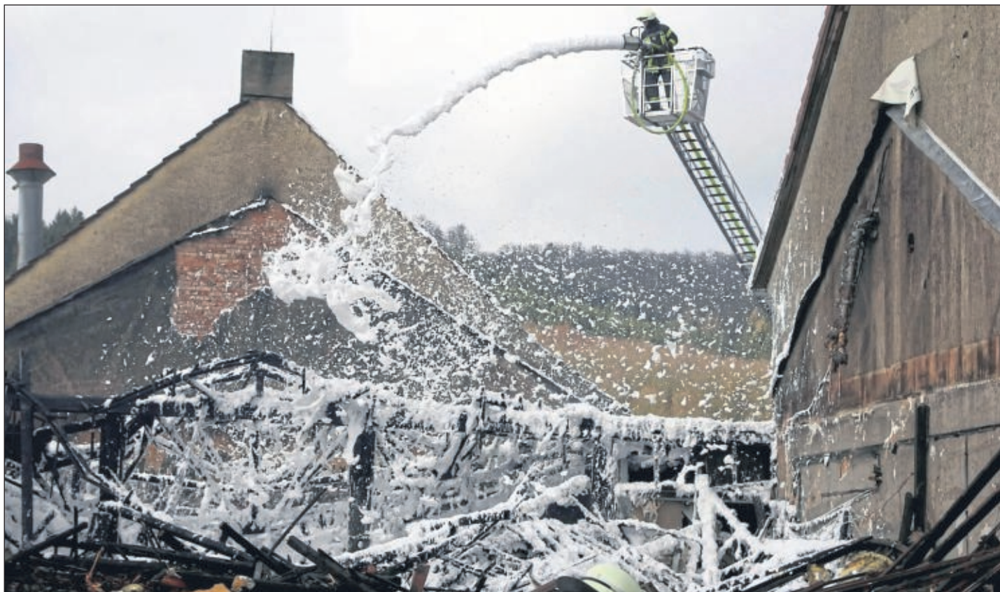
Schaumteppich: Damit sorgte die Feuerwehr nach dem Brand der Tischlerei dafür, dass nicht durch Glutnester andauernd wieder Feuer ausbricht.
